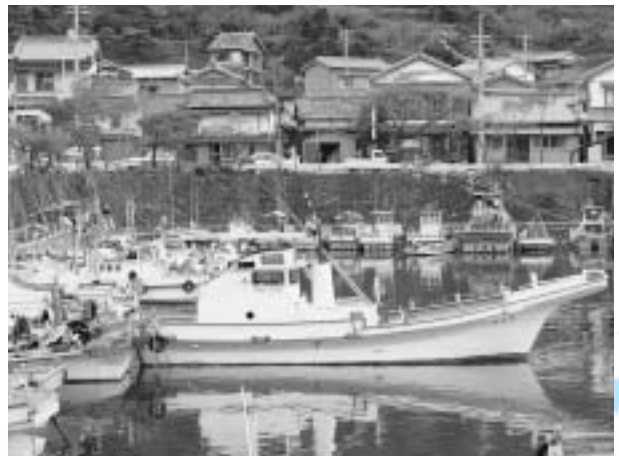
高知県夜須町にある手結港。日本最初の掘込み港として有名。現在は漁船が係留されている。
