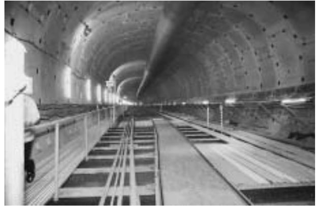
■セグメント組立後のトンネル坑内の全景(13号線神宮前工区)
