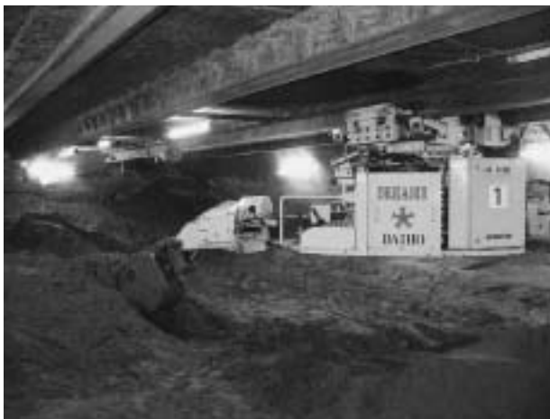
■ケーソン函内と掘削機
