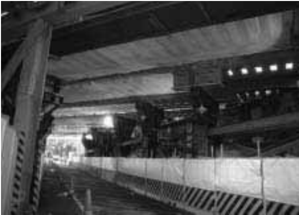
写真3 JR線仮受けの様子
