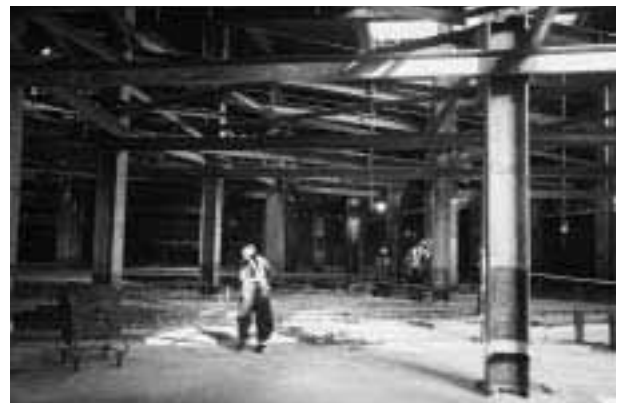
写真1 開削部地下の様子
