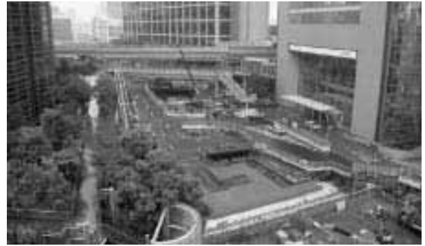
写真2 環2地下トンネル(仮称)築造工事全景
