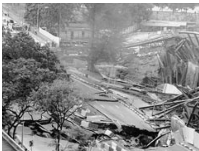
事故状況写真（シンガポール）
