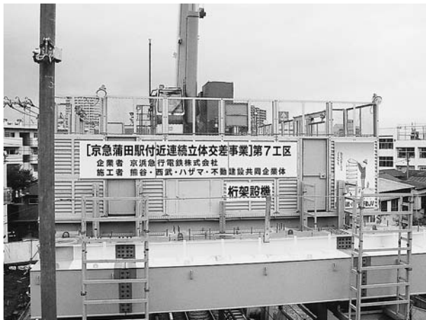
第7工区で使用されている桁架設機
