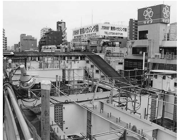
2層部分から見た第3工区
