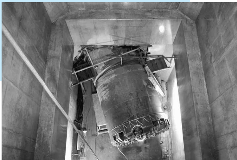
写真5 到達抜き出し完了後の状況
