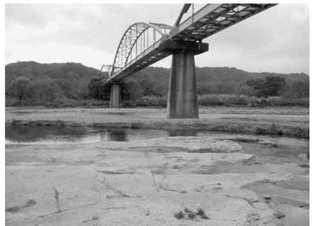
写真1 多摩川と水管橋（昭島市側より撮影）
