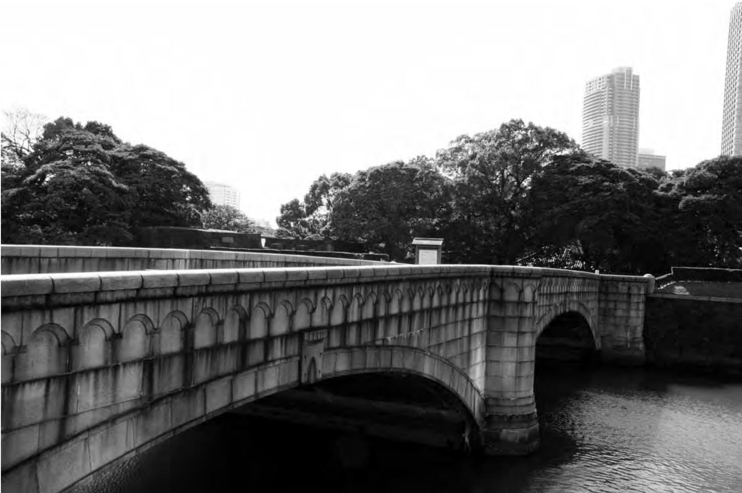
面で図式的にみると、まさしく凹と凸の字の相違にある。凹と凸の字の真ん中部分を横に引き伸ばした形を想像していただけるとよいと思う（図表(a)）。日本橋のように、縁周りを少し削って石の表面部分を突出させたのを、江戸切石仕上げ（図表(b)）というが、南門橋のように縁を突出させて石の表面部分を凹ませた切石仕上げの名称は、寡聞にして知らない。凹にしろ、凸にしろ、なぜこのような仕上げをおこなうのか。表面に凹凸ができ、陰影ができて構造物に表情が生まれるからだ、と思う。だが凹面仕上げの石は、いままであまり見たことがない。それにこのような仕上げは、石にとって得策ではない。縁の出っ張りが欠けやすくなるからだ。石の節理をあまり気にせず、機械で切石加工する現代では、このような意匠は絶対といってよいくらい採用しない。
