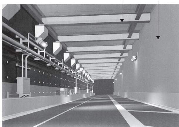
図11 ● 耐火パネル設置状況
