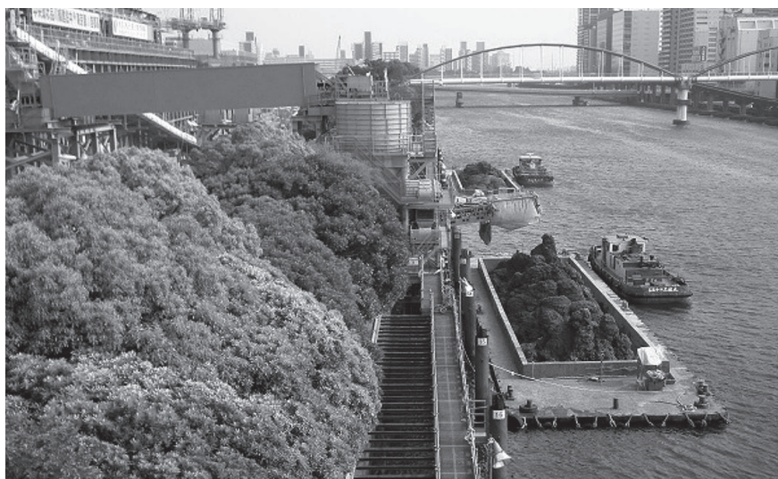
京浜運河残土積込状況
