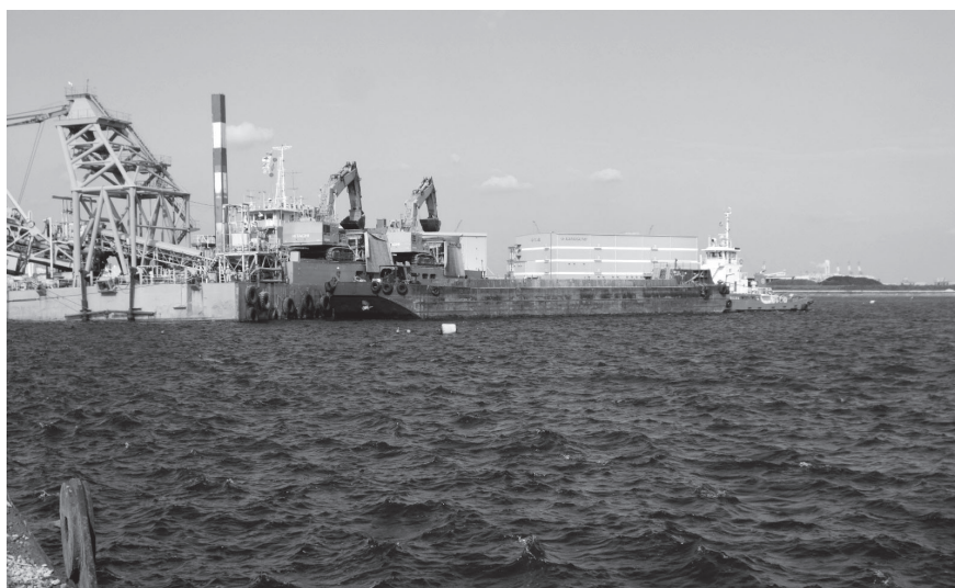
横浜港南本牧ふ頭への運搬状況
