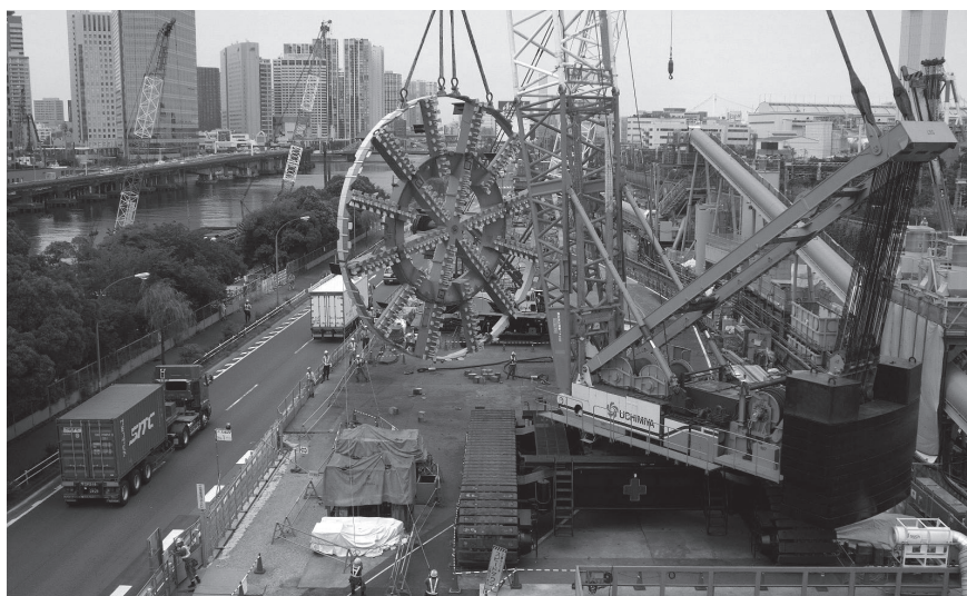
カッターヘッド投入
