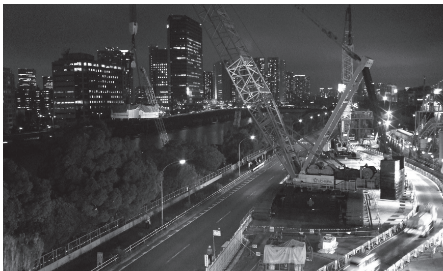
シールドマシン夜間搬入
