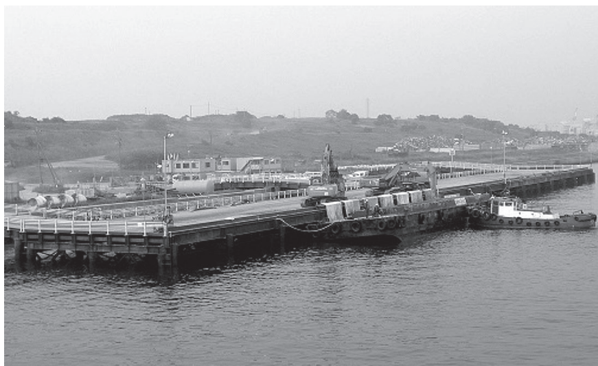
中央防波堤残土揚土状況
