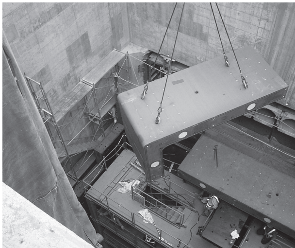
写真13 ● 1期施工函体推進施工状況
