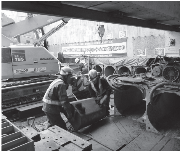
写真11 ● 水平箱型ルーフ施工状況
