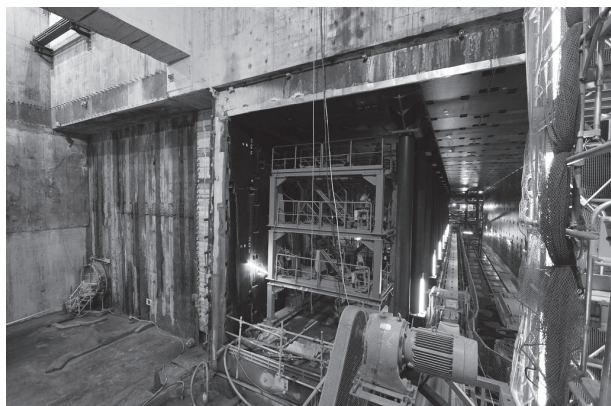
写真9 ● 発進立坑2期施工前
