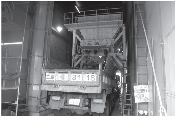
写真5 ●土砂ホッパーによる土砂積み込み状況
