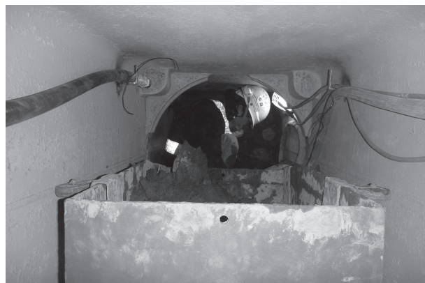
写真10 ● 箱型ルーフ内人力掘削状況
