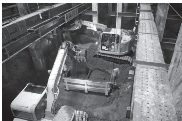
写真1 ● ベッセル積込状況
