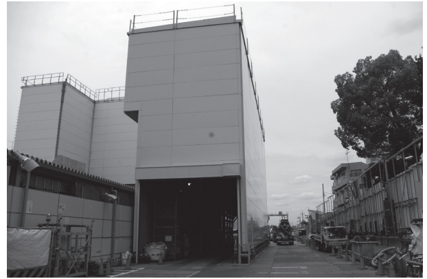
写真4 ●4工区内防音ハウス
