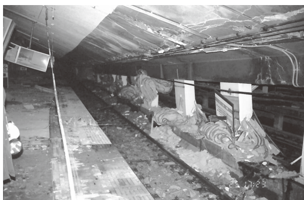
写真4 中柱のせん断破壊による地下鉄駅舎の破壊 (1995年兵庫県南部地震)
