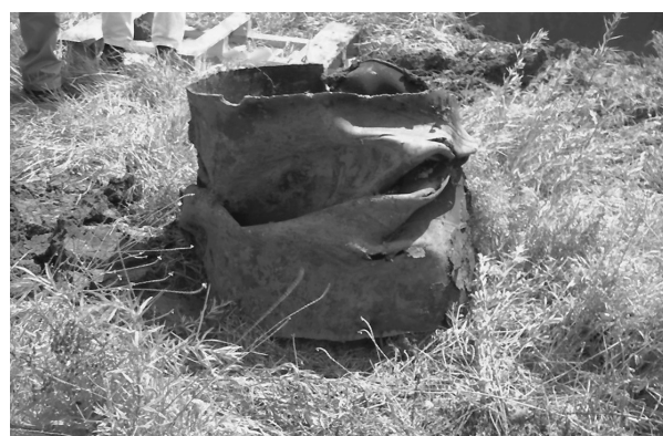
写真2 圧縮により局部座屈した管路 (1999年トルコ・コジャエリ地震)
