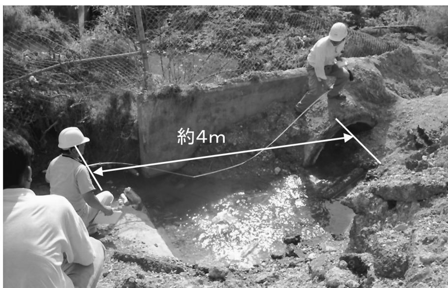
写真3 ヒューム管が横ずれ破断した例 (1999年トルコ・コジャエリ地震)
