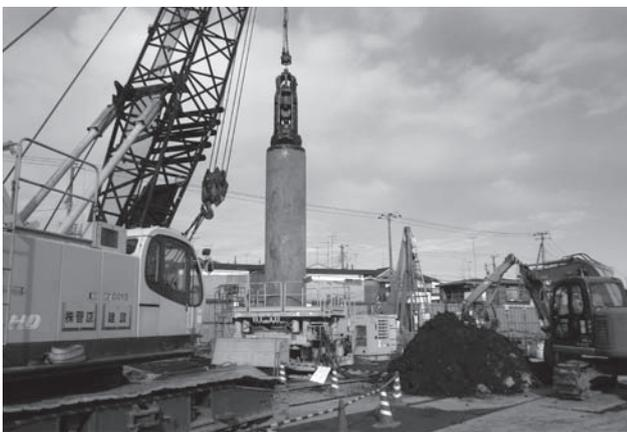
写真-2 深層部通水対策 オールケーシング工法
