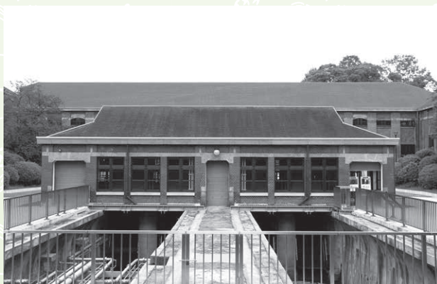
手前の「沈砂池」で下水中の土砂を沈殿させ、さらに奥に控える「ろ格室」のスクリーンで浮遊するゴミなどを除去した。いずれも文化財に指定された施設だ。
