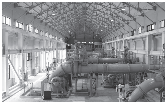
ポンプ室の内部はアーチ型のキングポストトラス構造の鉄骨によって支えられている。平成11年まで稼働していた10台のポンプや揚重機がそのまま保存されている。
