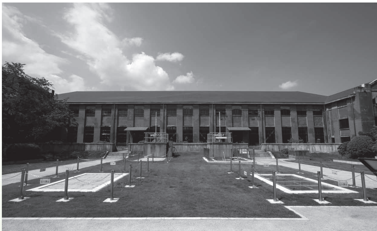
東西に両翼をひろげるポンプ室。規則的に配された柱と、平面的な梁、軒が左右対称の整然とした外観を構成している。(提供：東京都下水道局)
