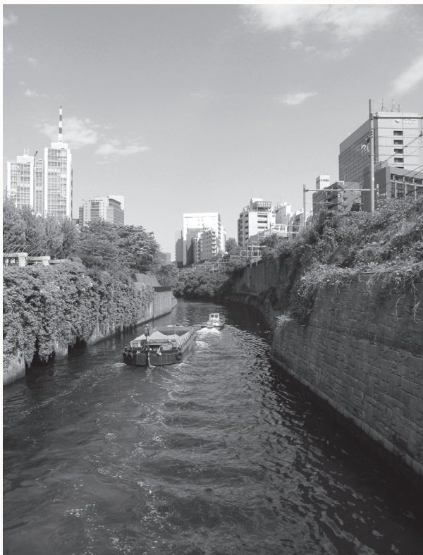
現在の水道橋のやや下流側に、神田上水の懸樋が通っていた。
