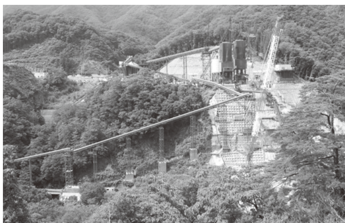
上／巡航RCD工法により施工が進められる堤体工事現場
