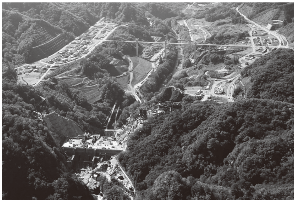
写真-1 全景写真
