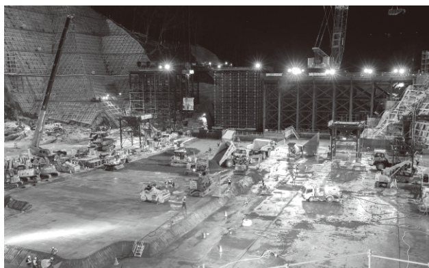
写真-2 打設状況(巡航RCD工法)
