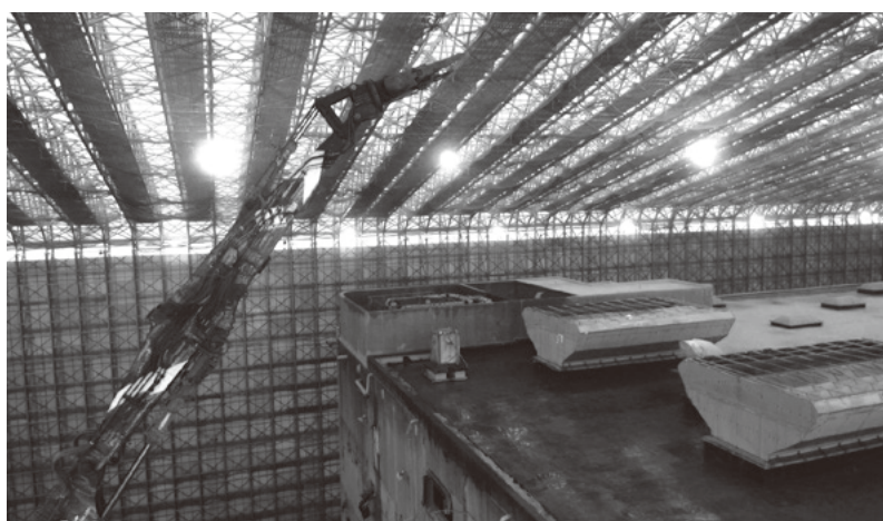
第4回目放送、目黒区の清掃工場では、建物がまるごと覆われ、その内部で、アームの長さ39mという重機で解体が行なわれた。
