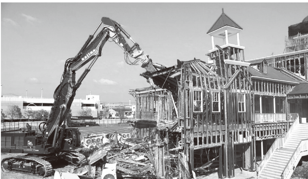
巨大重機による解体映像も番組の呼び物。写真は第2回目放送、横浜での現場風景。©NHK
