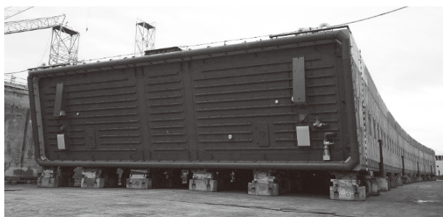
写真-2 沈埋函鋼殻製作状況（造船ドック）
