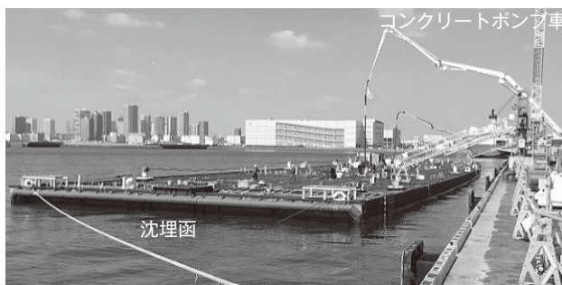
写真-3 沈埋函高流動コンクリート打設状況（浮遊打設）
