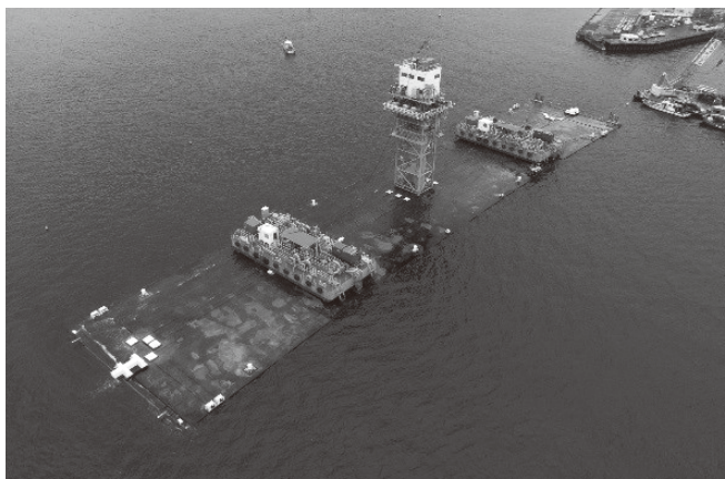
写真-4 沈埋函沈設状況（6号函）
