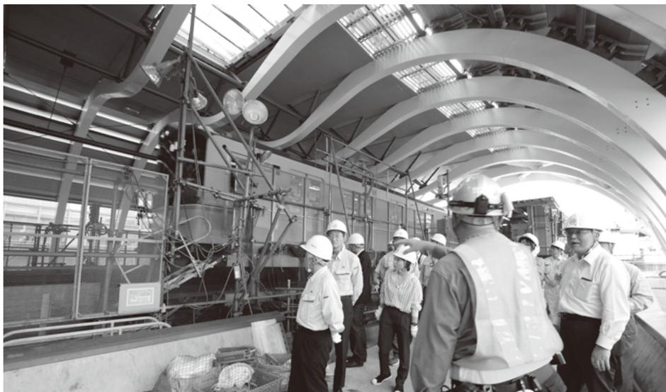
右／銀座線が走るそばで伊藤所長による詳しい解説に耳を傾ける見学者一同。屋根は、現場の構台で組み立てたM型アーチをスライド工法で施工。年末年始に第3回線路切替が行われる予定で、1月に新ホームの供用開始が始まる。下／屋根上に設けられたスカイデッキ。左は11月1日に開業する「渋谷スクランブルスクエア」で地上47階建ての超高層ビル。
