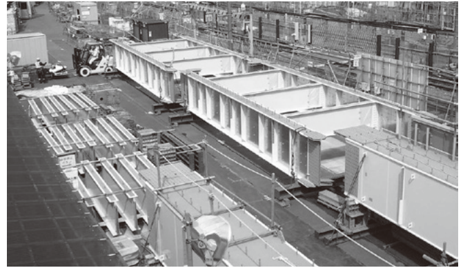
写真-2 地組ヤード
