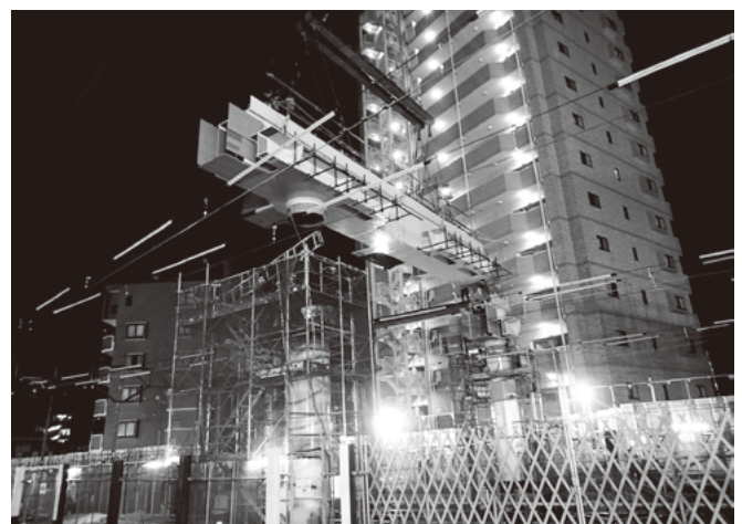
写真-4 仕口・梁 一括架設
