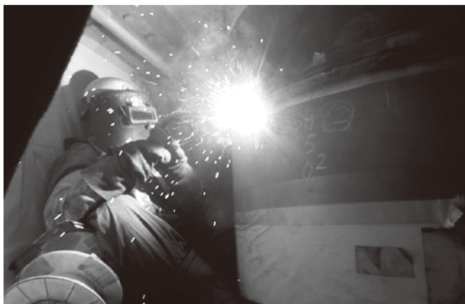
写真-5 風防設備内での溶接作業
