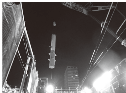
写真-3 柱一括架設
