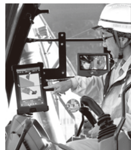
MCバックホウのモニターにはガイダンスが出て、細かい操縦なしに自動施工が可能だ。
