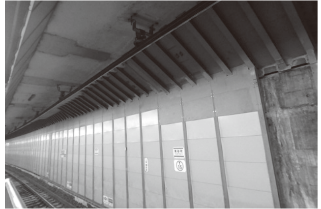
写真-3 構内防護壁設置状況
