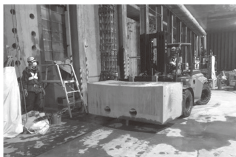
写真-5 側壁撤去状況写真(7tフォークリフト)
