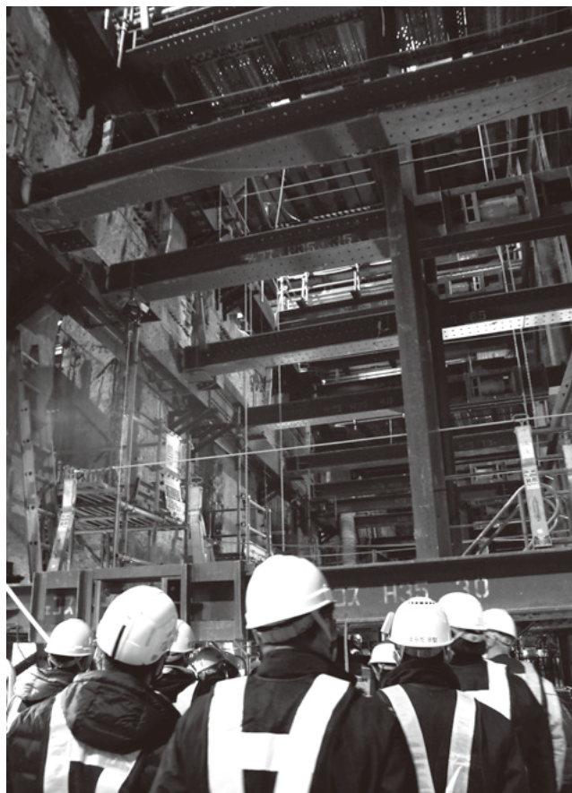
現場の直上には都道が走り、多くの自動車が行き交う。交通を阻害しないように工事は進められている。
