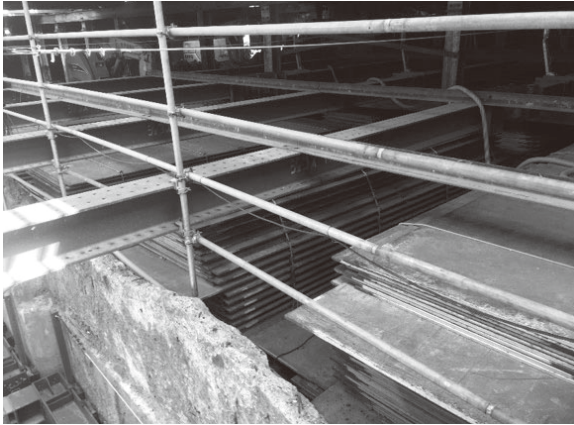
写真-2 敷鉄板設置状況
