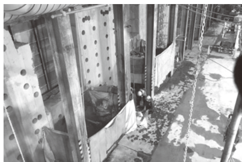
写真-4 側壁撤去状況写真(ワイヤーソー水平切断)
