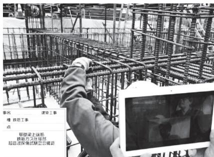
Webカメラを利用した遠隔検査
