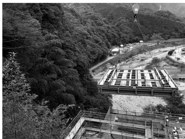
図-14 プレファブ部材 積層状況
