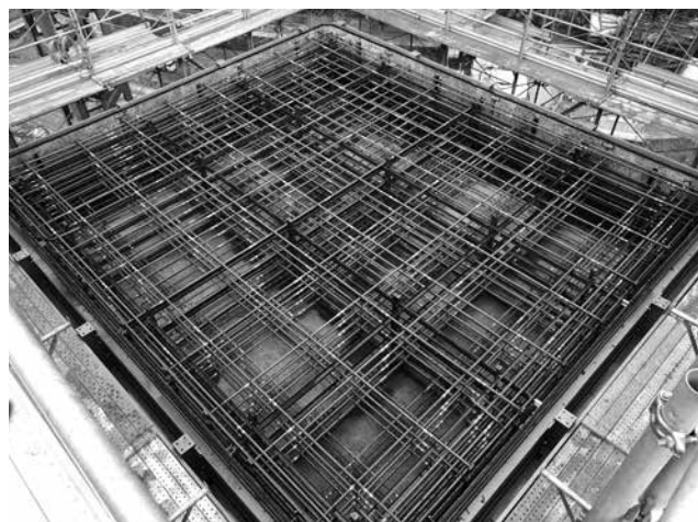
図-13 埋設型枠と帯鉄筋のプレファブ化状況
