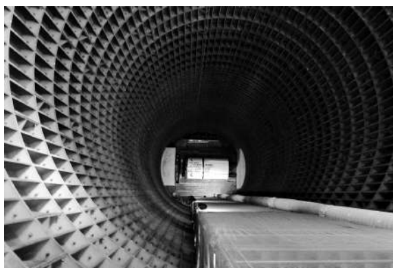
写真-16 立坑上からみたシールド機
