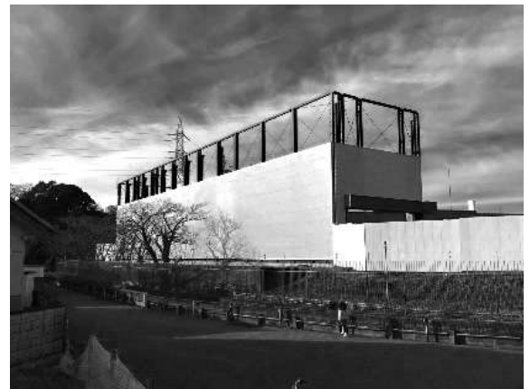
写真-9 先行防音壁全景 (民家側から撮影)
