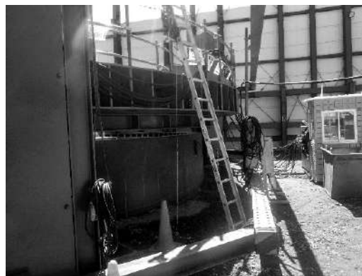
写真-14 昇降用アルミ梯子
