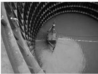
写真-5 高圧洗浄機による 洗浄状況
