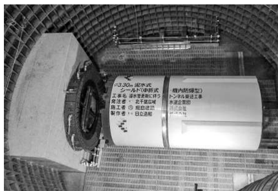
写真-17 立坑下に据付けたシールド機
