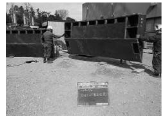
写真-2 刃口リング組立状況
