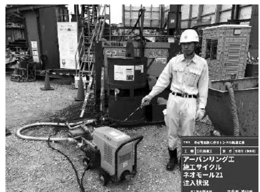
写真-13 ネオモール注入状況
