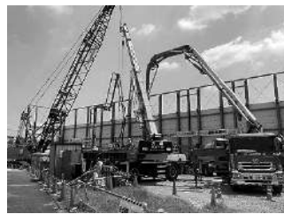
写真-6 水中コンクリート 打設
