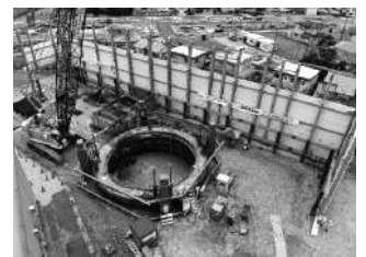
写真-3 掘削状況
