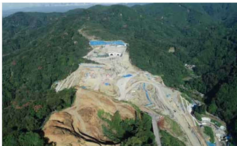
図-2 川西工事（塩沢工区）
