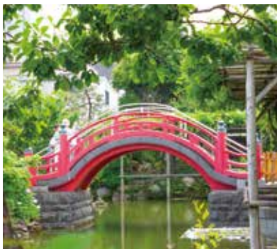
戦火により橋は木製から鉄筋コンクリート造へと変わったが、藤棚と水面に映える半円形のアーチが織りなす景色は江戸から変わらずそのままだ。
