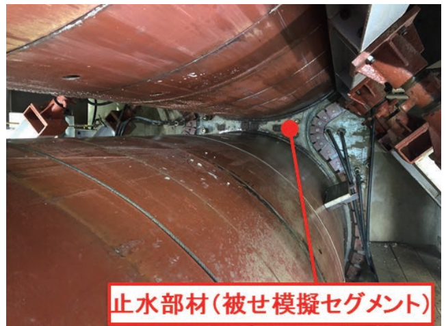
写真-8 止水部材押込状況
