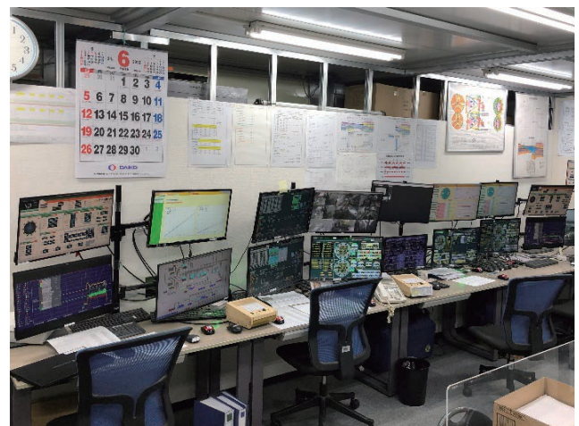
写真-6 掘進管理システム
