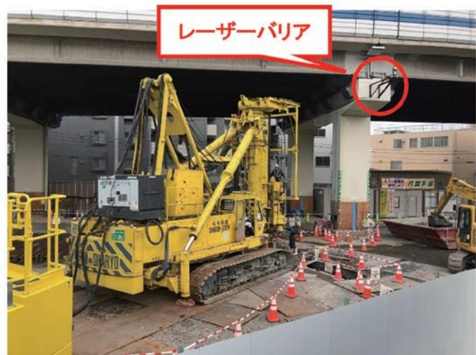
写真-2 影響遮断壁（SMW）施工状況
