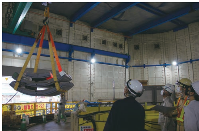
地上ヤードから立坑へ運搬されるセグメント
