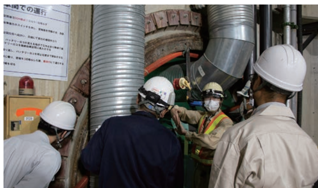
坑口で説明する現場職員と、熱心に聞く参加者
