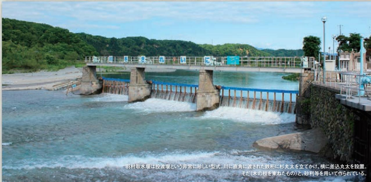
羽村取水堰は投渡堰という非常に珍しい型式。川に直角に渡された鉄桁に杉丸太を立てかけ、横に差込丸太を設置。そだ(木の枝を束ねたもの)と、砂利等を用いて作られている。
