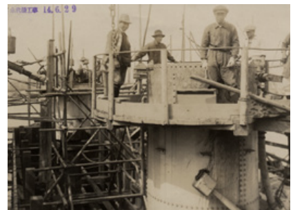
関東大震災復興工事関係写真・永代橋工事(大正14年6月29日)(土木学会附属図書館デジタルアーカイブス所蔵)
