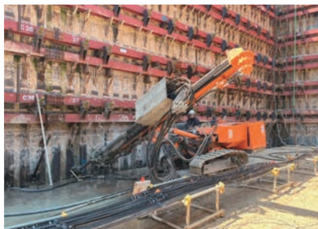
【図-10】アースアンカー施工状況
