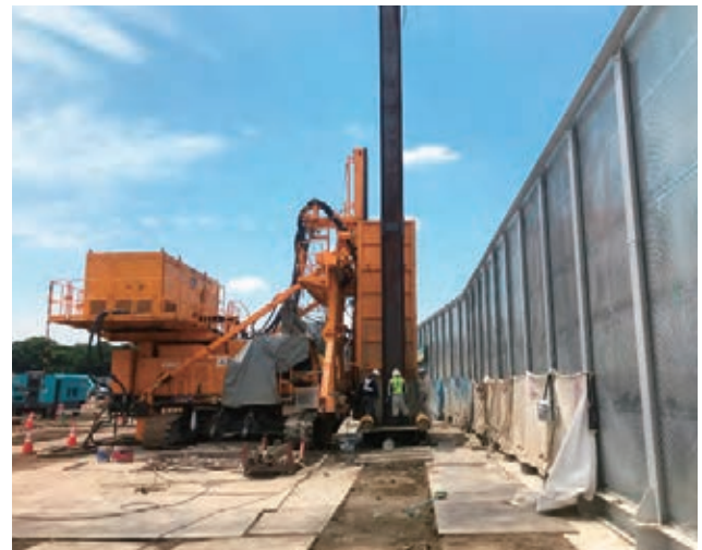
【図-5】 地中連続壁の施工状況
