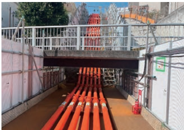
【図-14】 深堀川に敷設した圧送管
