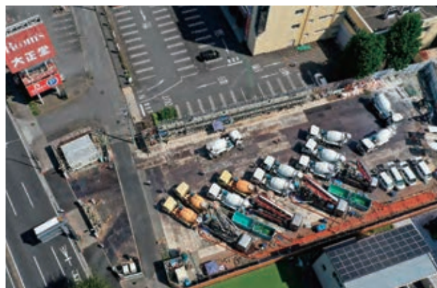
【図-13】圧送ヤード全景
