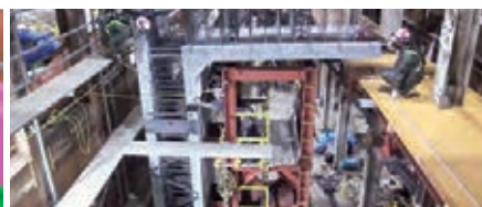
中詰めコンクリート打設前
