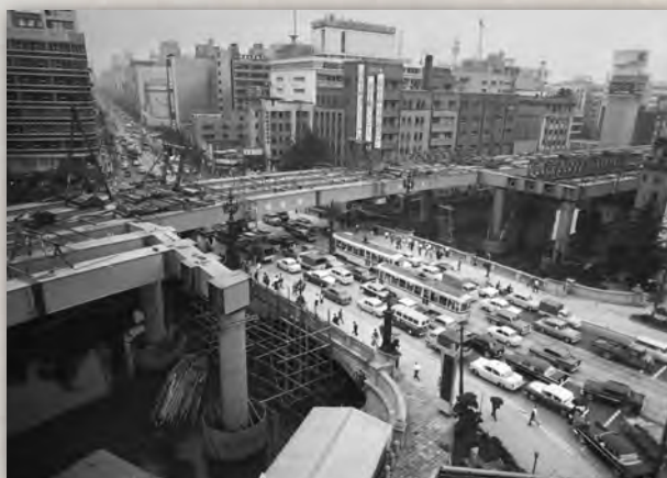
1963年(昭和38年)6月13日 首都高速道路4号線の架橋工事の様子(朝日新聞社 提供)
