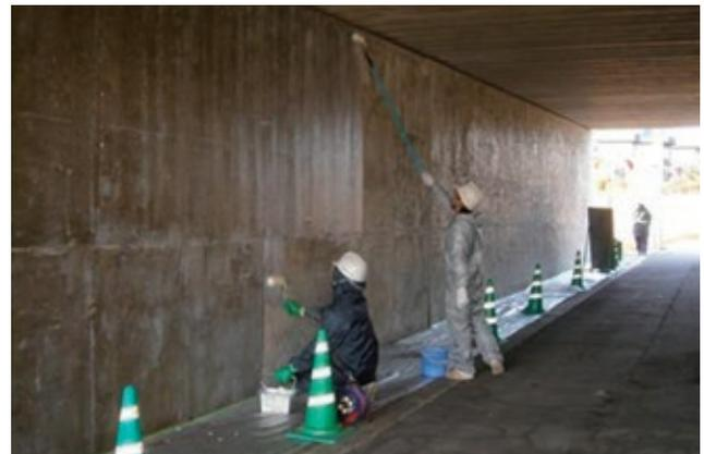
写真-3 表面含浸工法の施工状況
