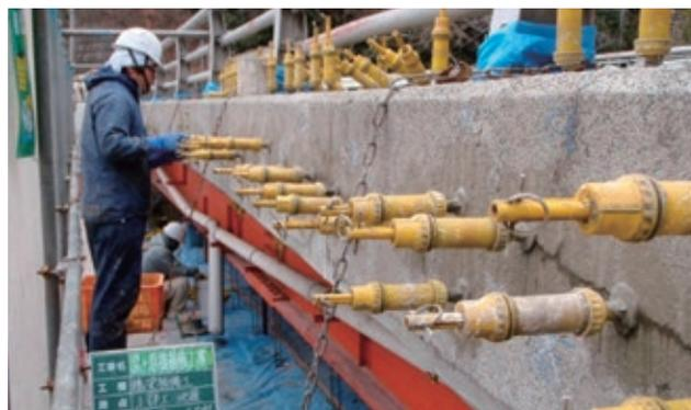
写真-1 ひび割れ注入工法の施工状況
