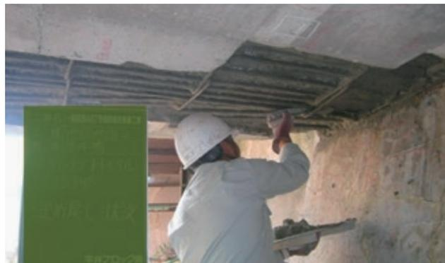
写真-2 部分断面修復工法の施工状況
