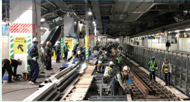
第5回線路切換工事状況(撮影協力:東日本旅客鉄道(株))
