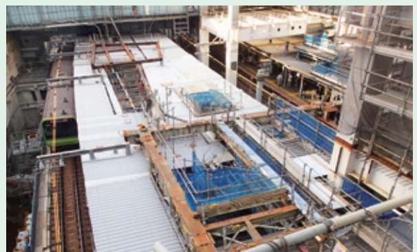
駅上空での施設解体・鉄骨架設状況(撮影協力:東日本旅客鉄道(株))
